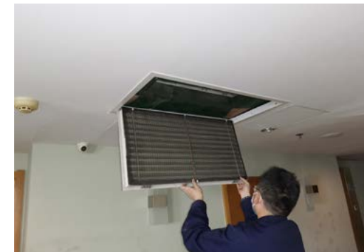
▲ 清洗空调滤网
