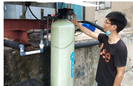
▲ 调试中央空调软水过滤设备
