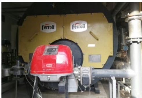
白洋淀学院更换燃气蒸汽锅炉
