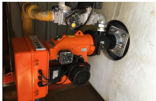
广州米兰花更换燃气锅炉燃烧机
