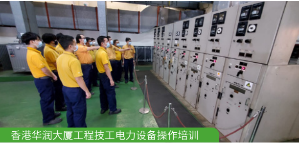
香港华润大厦工程技工电力设备操作培训
