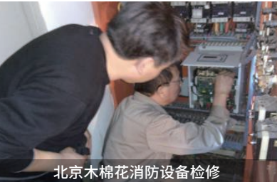
北京木棉花消防设备检修
