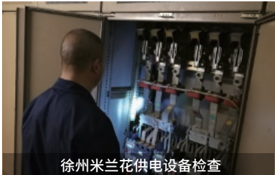
徐州米兰花供电设备检查
